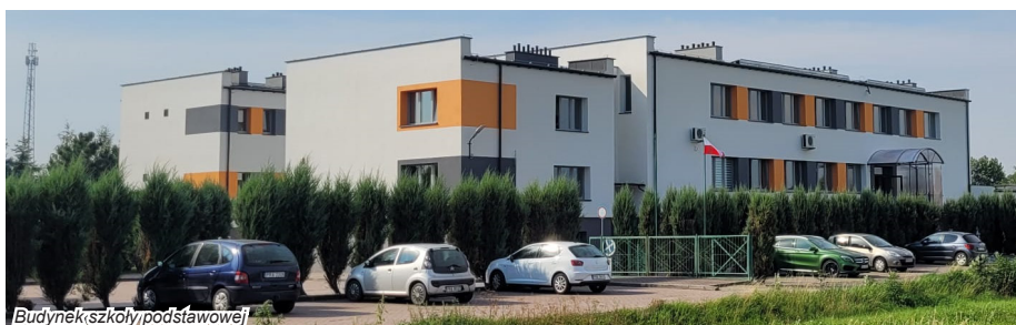
Budynek szkoły podstawowej
