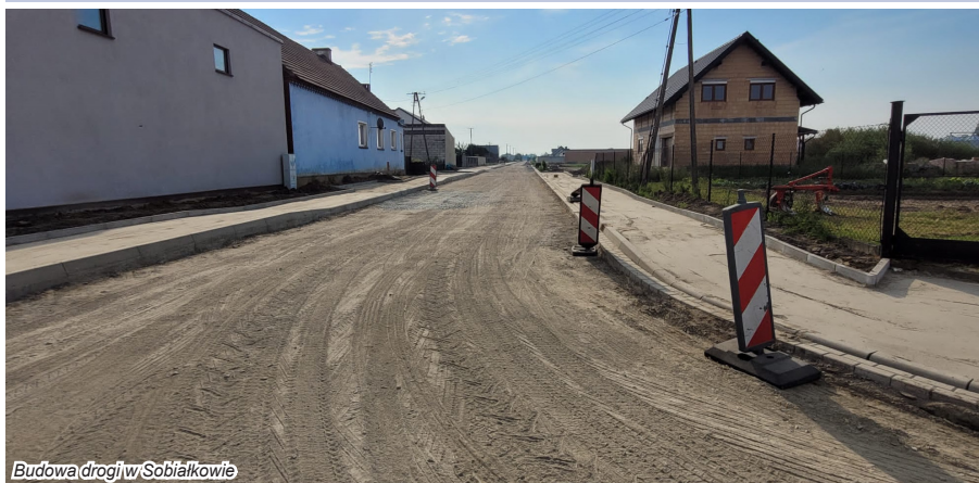
Budowa dróg w Sobiałkowie
