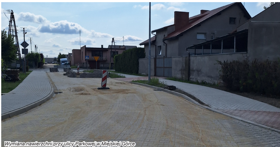
Wymiana nawierzchni przy ulicy Parkowej w Miejskiej Górcie
