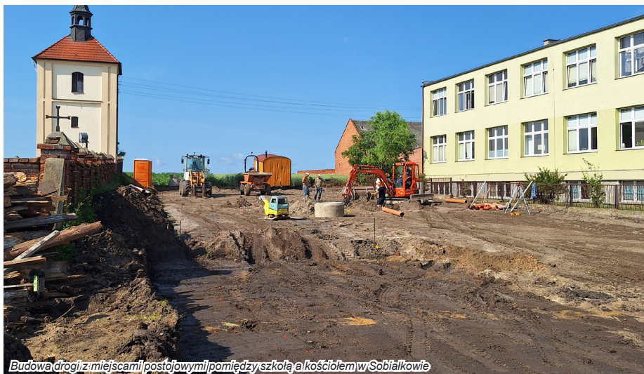
Budowa drogi z miejscami postojowymi pomiędzy szkołą a kościołem w Sobiątkowie
