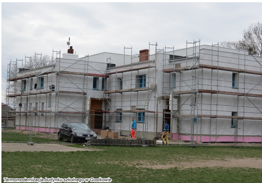
Termomodernizacja budynku szkolnego w Gostkowie
